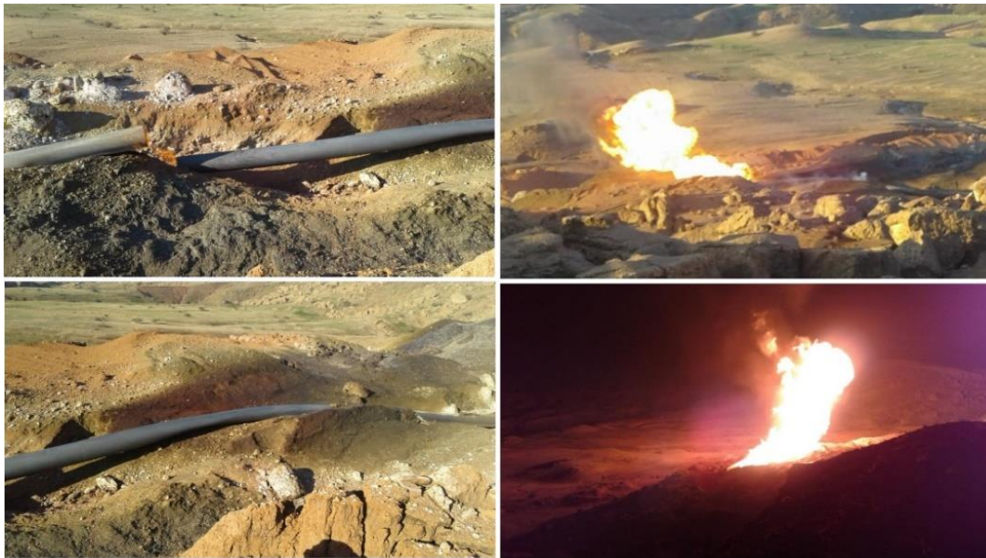
شکل ۲۶: موقعیت و تصاویر مربوط به انفجار ناشی از برون‌زدگی لوله گاز ۵۶ اینچ به دنبال وقوع سیلاب ۱۳۹۸ در سطح محدوده مورد مطالعه
