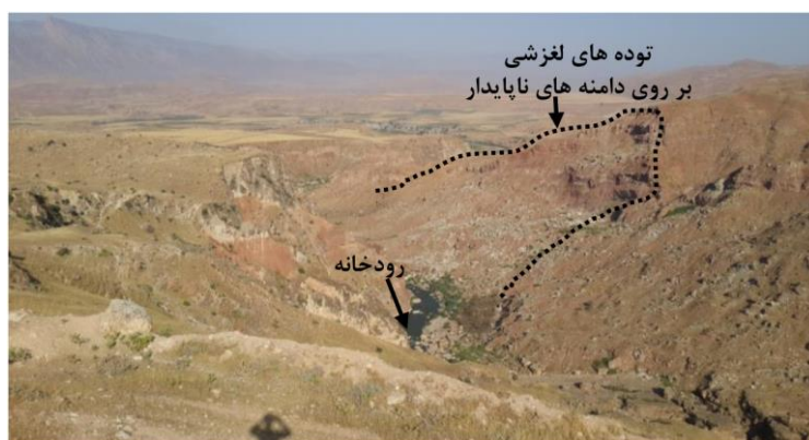
شکل ۴: مسیر جدید رودخانه کشکان و وجود دامنه‌های ناهموار و پرشیب در دو طرف آن
