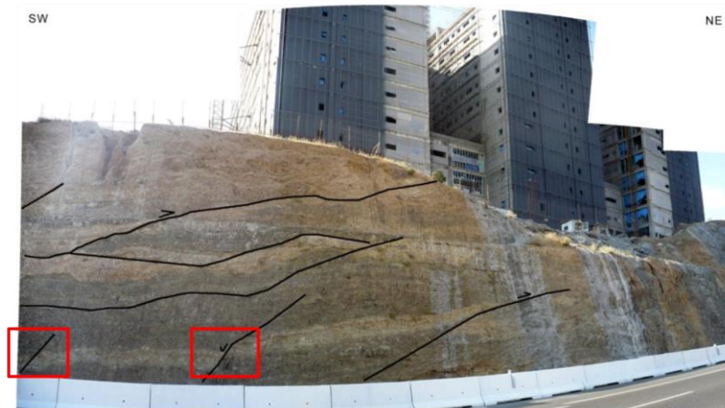
شکل ۸: ساخت مجموعه‌ای از برج‌های بلند (احتمالاً با کارکرد بیمارستان) در اتوبان همت، که به‌طور مشخص بر روی روندهای گسلی مرتبط با سامانه گسلی شمال تهران ساخته شده‌اند.
