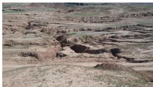
شکل ۶: گالی‌زایی در مناطق فاقد پوشش سطحی زمین که تخریب سرزمین به مرحله بحرانی رسیده است (کد ۱۵)
