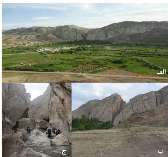
شکل ۴: الف) بخشی از کوه‌های تکه‌قیه‌سی که تنگ اندآباد در آن شکل گرفته است (بهار ۱۳۹۵). ب) محل ضربه شمشیر (نقاط ۱ و ۲) بر اساس فولکلور رایج در بین اهالی منطقه. ج) ریزش تخته‌سنگ‌ها در تنگ اندآباد (آذر ۱۳۸۸).
